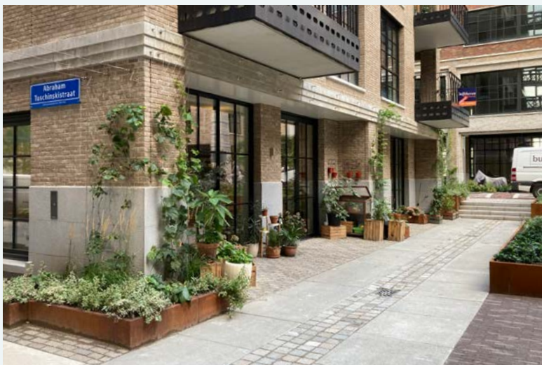
Bij Little C is veel aandacht besteed aan de plint en de overgangzone is mee-ontworpen: hier gaan grote raampartijen samen met een gevelzone.
